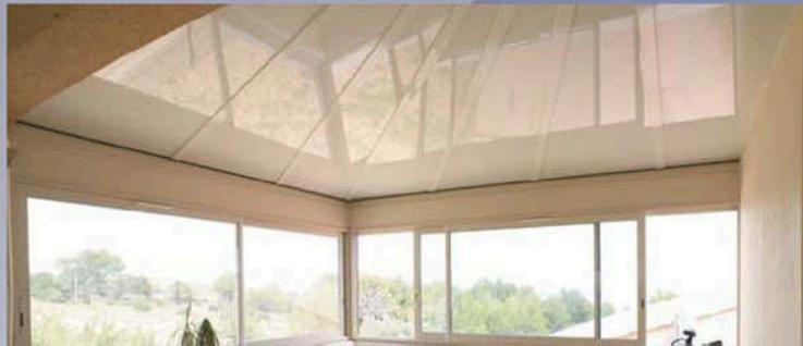
ils sont constitués d'une âme isolante en polystyrène extrudé et d'une masse élastomérique anti-vibratoire ce qui offre :
